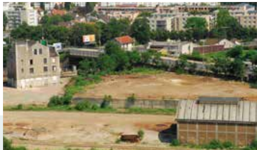
En septembre 2008, restauration extérieure du bâtiment des voyageurs après le départ du ferrailleux.
